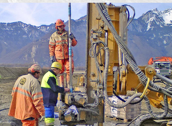
Messrohrinstallation in Bohrung
