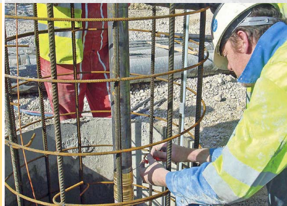
Installation Gleitmikrometer in Pfahl
