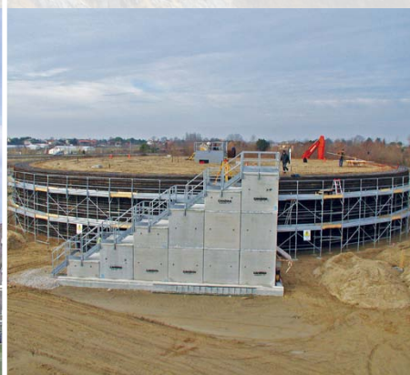
Konsolidationsversuch: Venedig, Bocca di Lido
