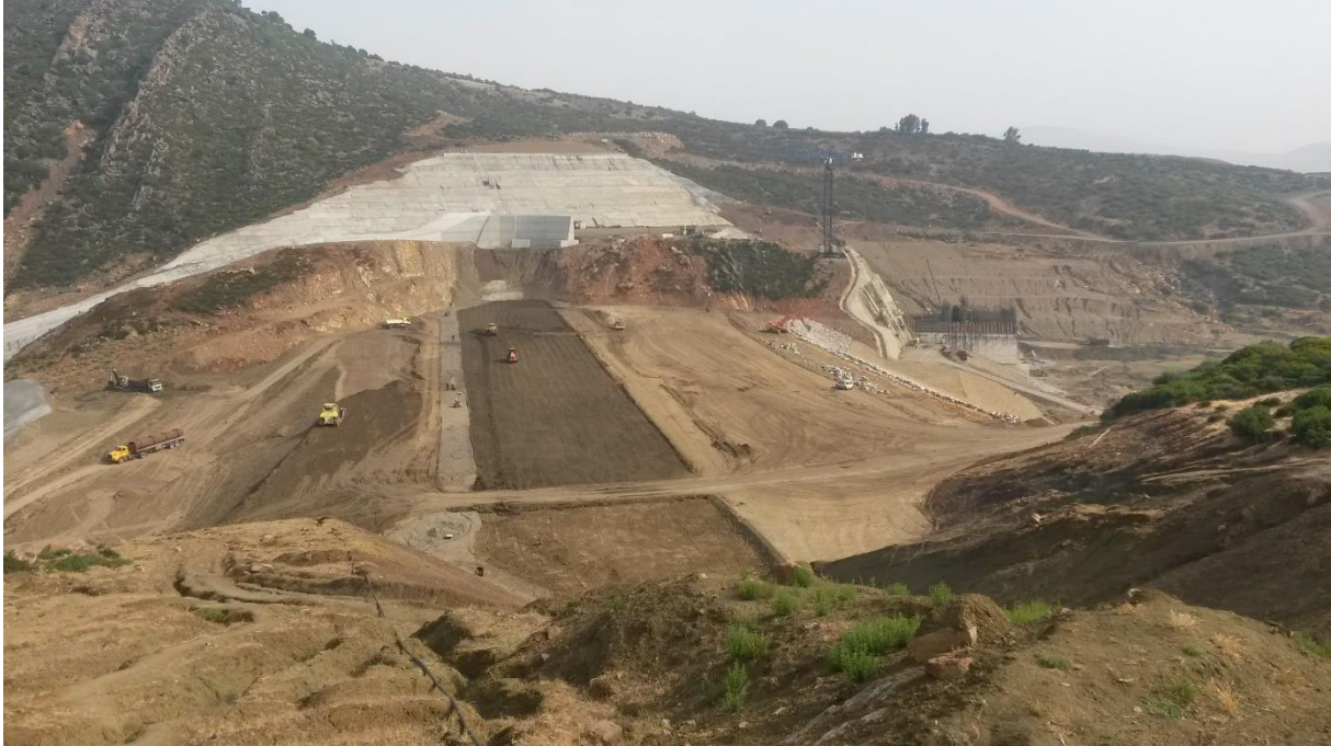
Bau des Dar Khrofa Dammes
