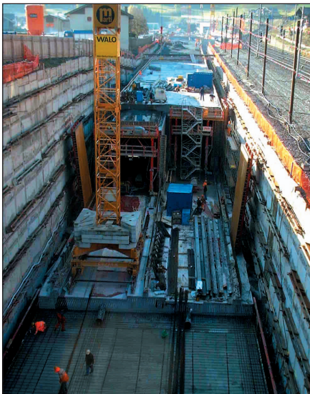
Fouille de Frutigen en construction (Solexperts, 2003)
