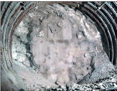
Extrusion du massif après excavation dans le St.-Gothard (Solexperts, 2006)
