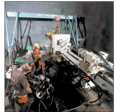
Foration par la société Morisette en front de taille, une des 2 foreuses visible sur le cliché (Solexperts, 2003)
