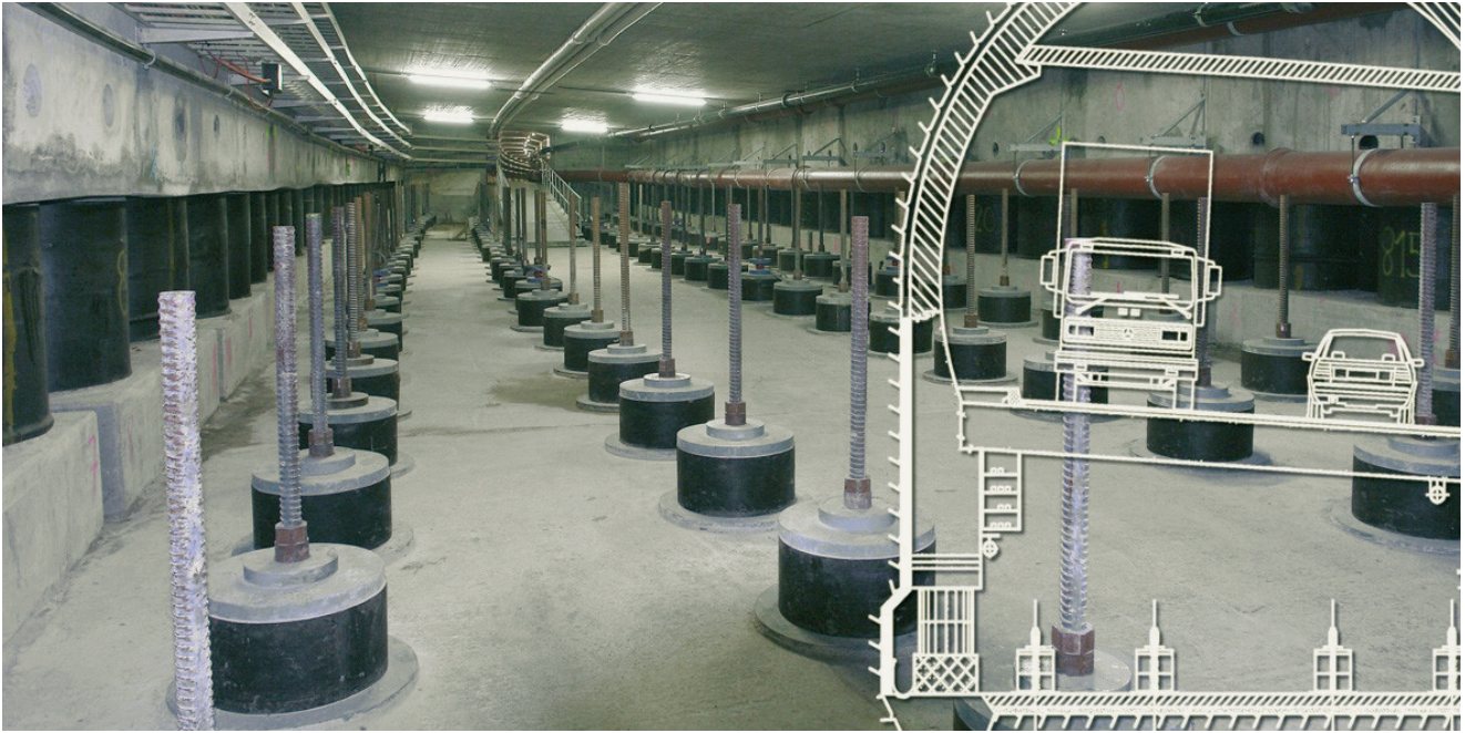
Fig. 6: Tunnel de Chienberg - zone du radier, en dessous du tablier
