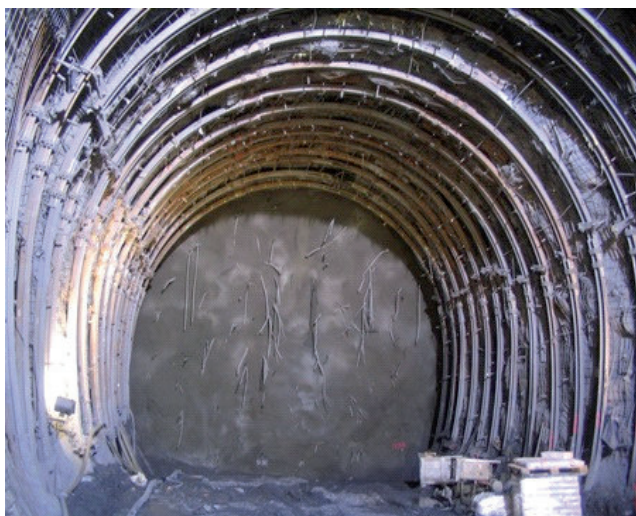
Photo 4 - Profil de soutènement souple de type 1
