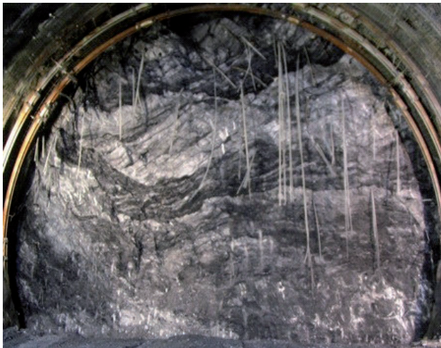
Photo 3 - Front de taille dans les schistes carbonneux du Houiller productif
