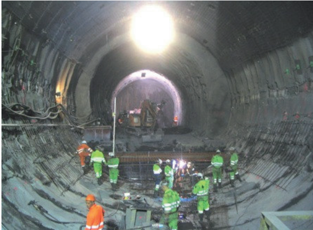
Photo 9 - Soutènement intermédiaire semi-rigide Réalisation de la contre-voûte
