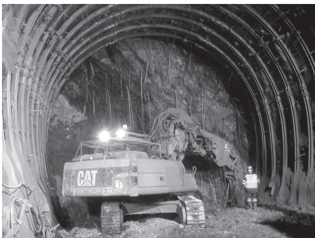
Photo 2 - Excavation au PM 1350
