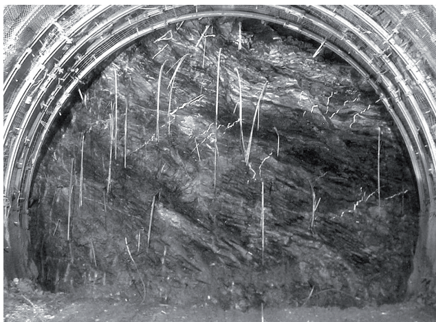
Photo 1 - Vue du front et des terrains du Houiller au PM 1414
