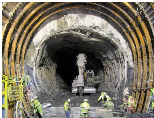
Photo 6 - Réalisation de l'anneau béton avec un coffrage perdu, après réalésage de la section
