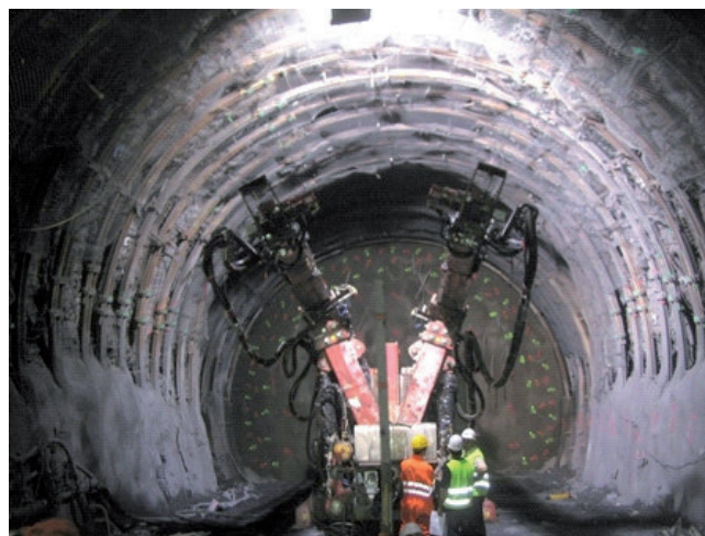
Photo 8 - Consolidation du massif en avant du front
