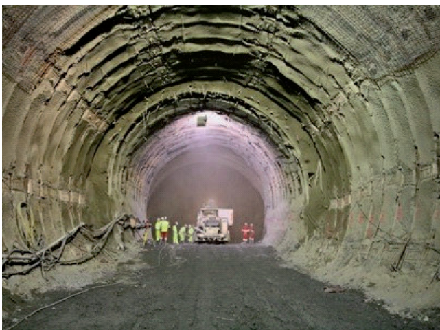
Photo 10 - Soutènement intermédiaire semi-rigide Réalisation de la voûte avec insertion de blocs compressibles
