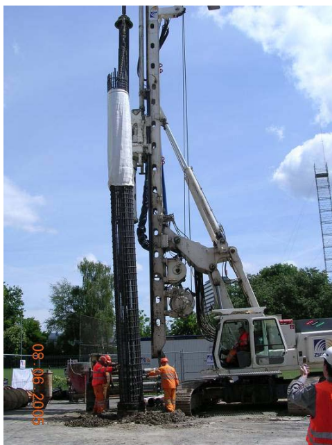
Bild 4: Einbau Pfahlarmierung
