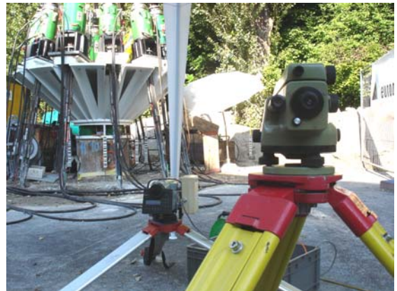
Bild 9: Messungen am Pfahlkopf mit Präzisionsnivellement
