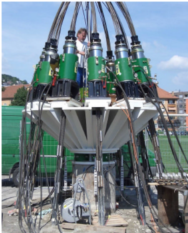
Abb. 8: Pfahlbelastungsversuch mit Gleitmikrometermessung
