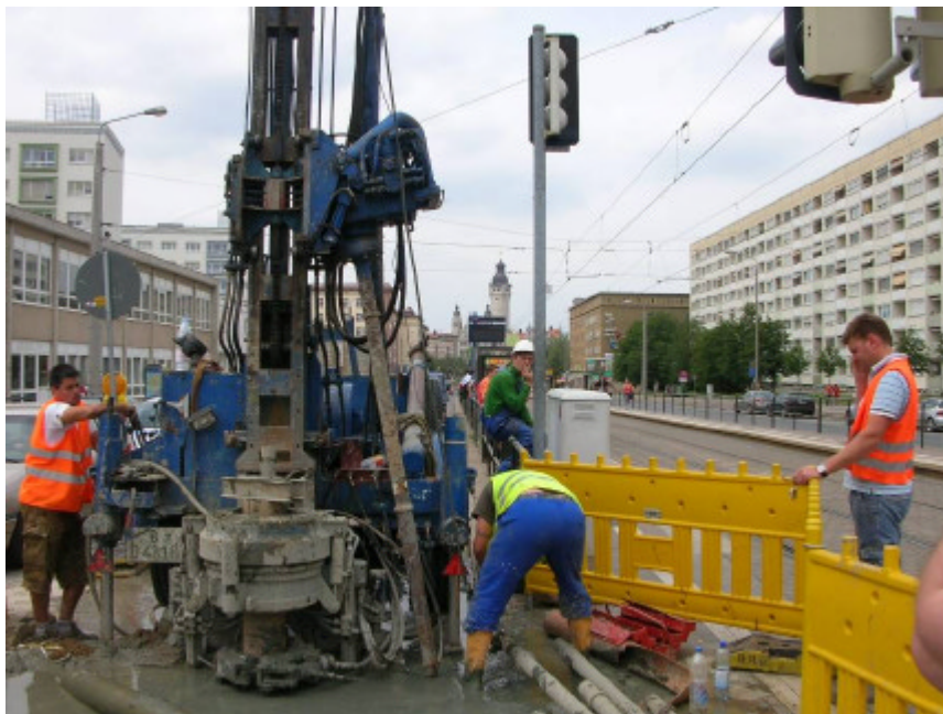
Abb. 3: Messrohrinstallation in Pfählen
