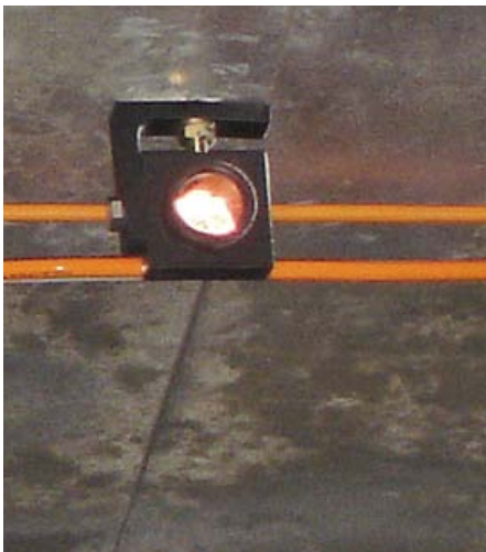
Beobachtungspunkt an der Tunneldecke
